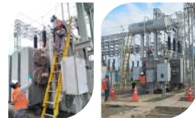
Reemplazo de aceite en conmutadores de transformador de potencia TP-6015 de la SET Chiclayo Norte.
