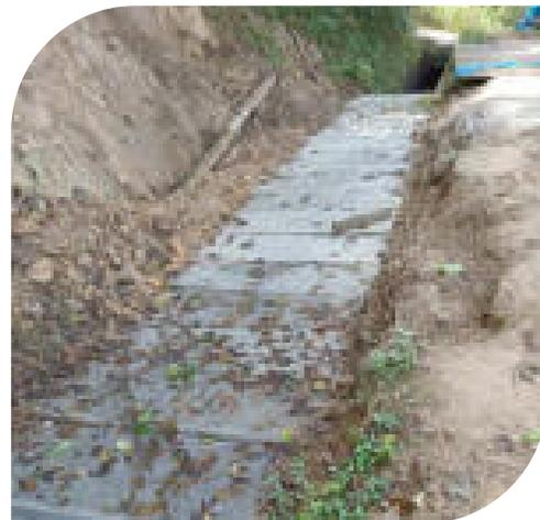
Recuperación de 8 m del canal de conducción en la Prog. 1+540
