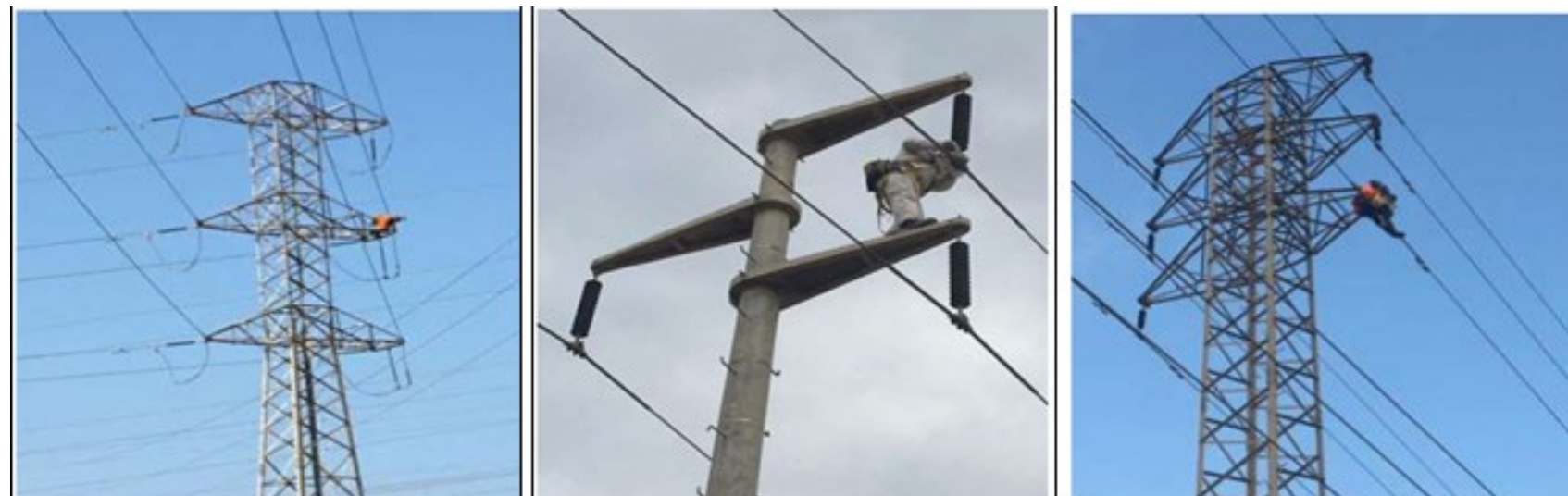
Limpieza en frío del aislamiento en las Líneas de Transmisión de 60 kV y 138 kV.
