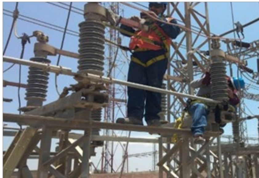
Lubricación de seccionadores de potencia y Pruebas eléctricas de interruptores de potencia
