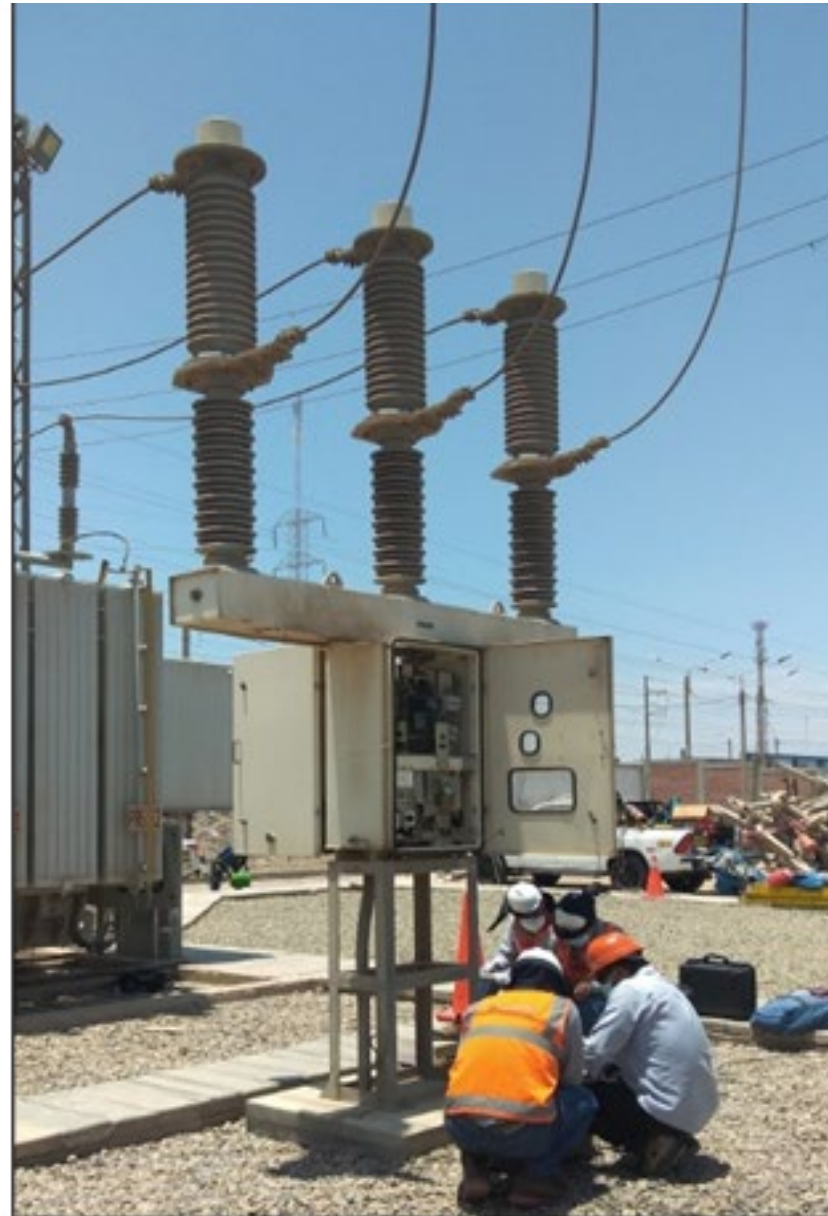
Lubricación de seccionadores de potencia y Pruebas eléctricas de interruptores de potencia
