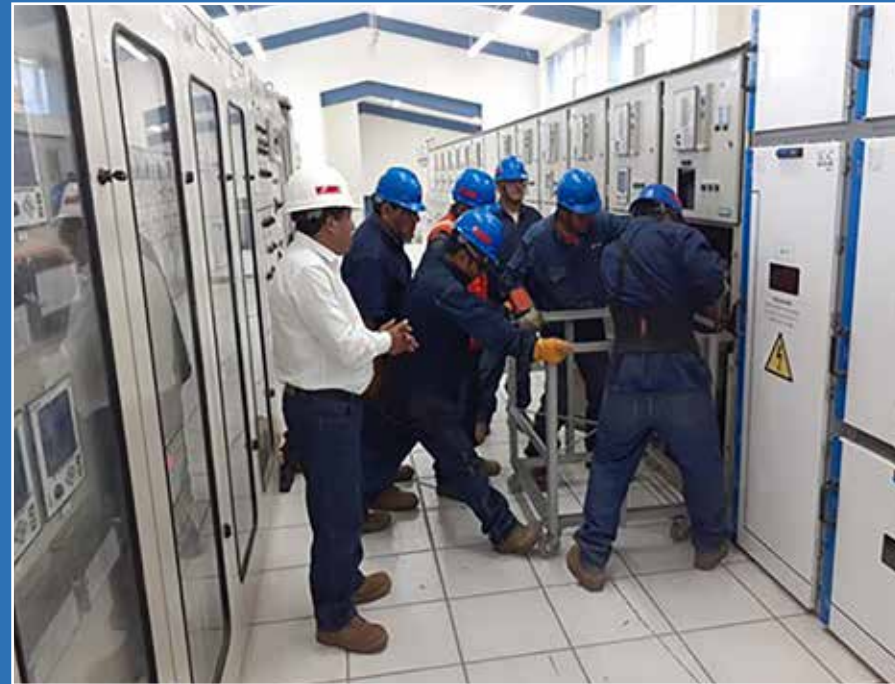
Mantenimiento a celdas 10 kV en la SET Chiclayo Oeste
