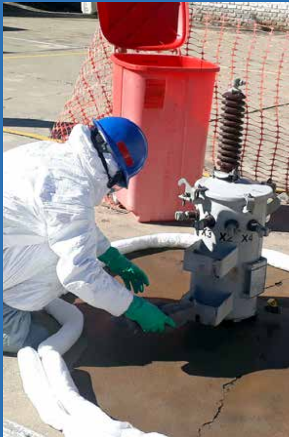
Descarte de PCB en aceite dieléctrico de transformadores UE Huaráz.
